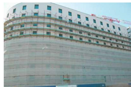
Ostello in costruzione alla ex Vempa
