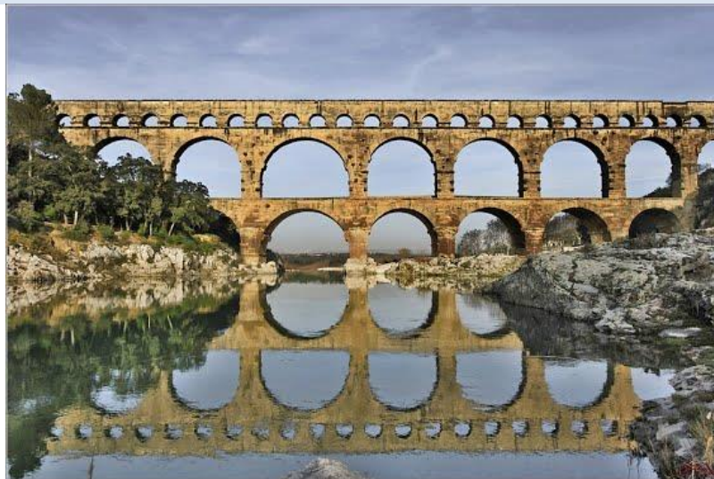
Pont du Gard 17 a.C. Francia
