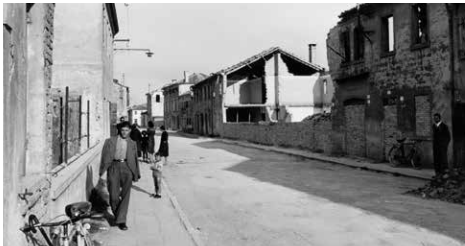
Effetti del bombardamento in via Mestrina (archivio del Duomo di Mestre).
