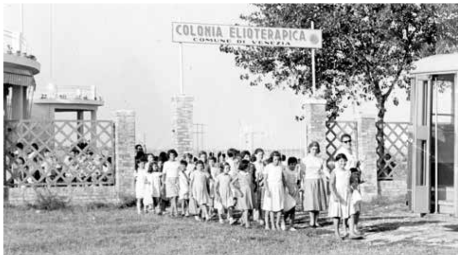
Ingresso della colonia elioterapica di San Giuliano (Sergio Barizza).
